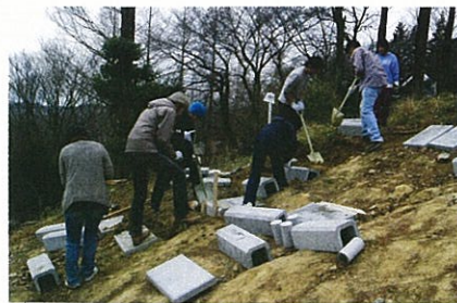
■ 削られた大地に、土留めのブロックを築く
